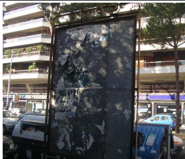
Corso Trieste: impianto fatiscente
