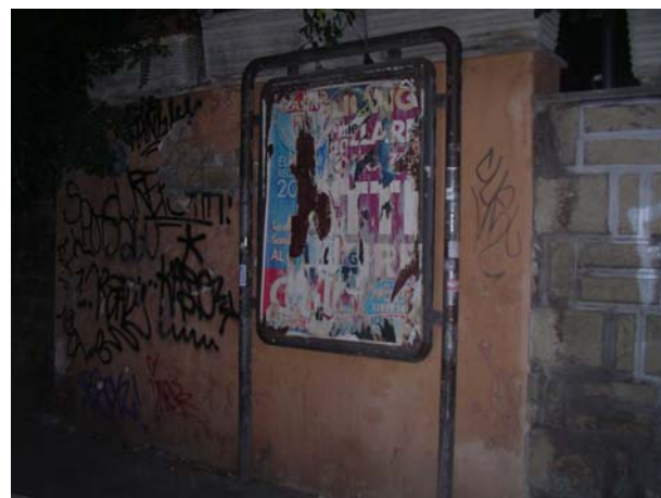
Viale Trastevere: altro impianto arrugginito e inutilizzato
