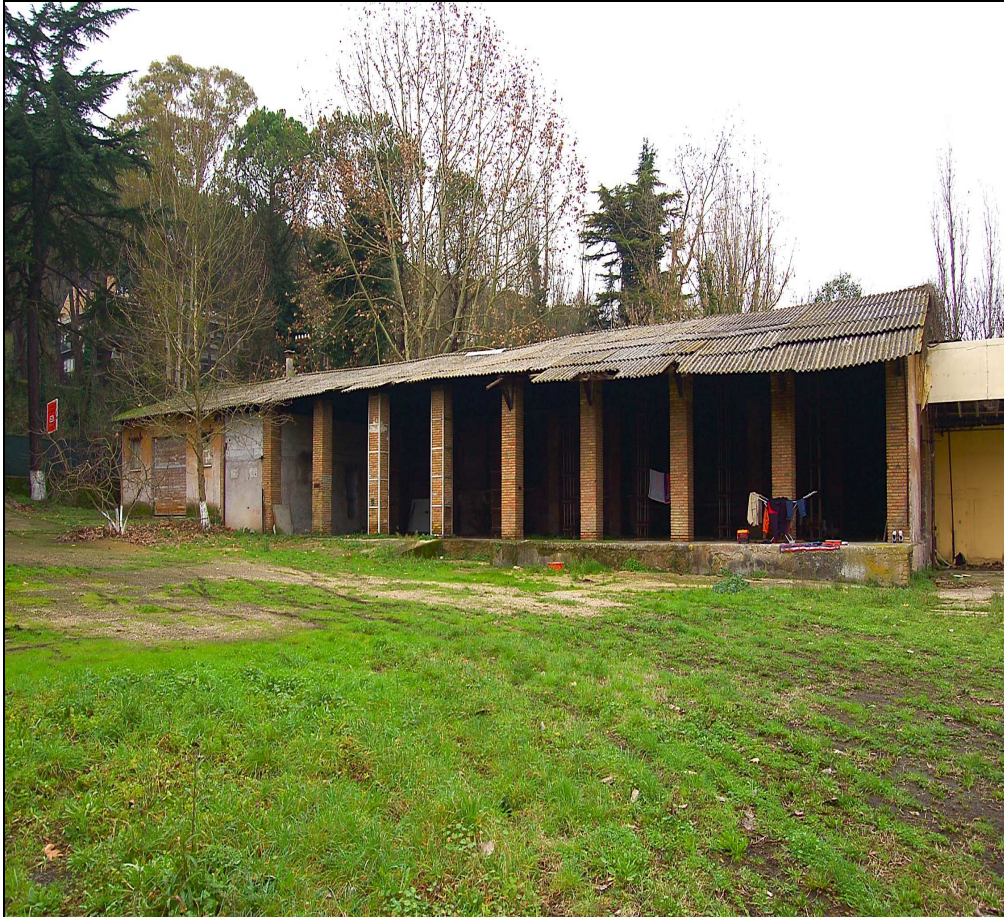
Veduta dei medesimi 3 fabbricati accorpati a sinistra dell'entrata, con il porticato centrale
