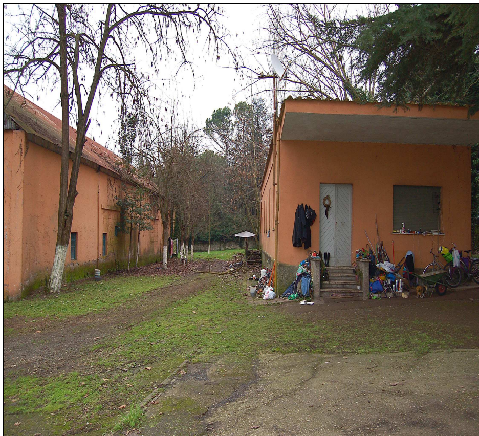
Veduta del fronte del fabbricato immediatamente a destra dell'entrata (part. n. 51, sub 1), con a fianco il fabbricato retrostante (part. n. 48, sub 3), entrambi paralleli a via Cassia Antica
