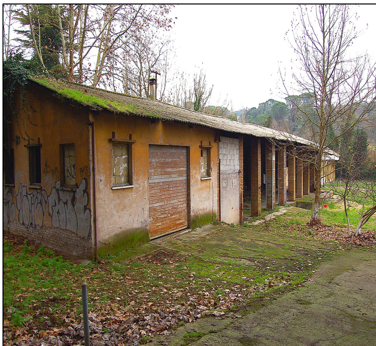
Veduta d'insieme del fianco dei 3 fabbricati accorpati a sinistra dell'entrata (part. n. 50, 49 e 148)
