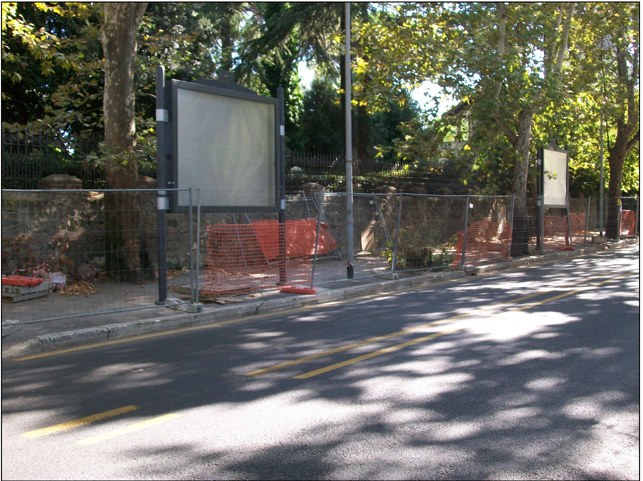
Impianto pubblicitario installato in viale di Tor di Quinto all'altezza del civico n. 60, sul lato Tevere, segnalato da VAS con messaggio di posta elettronica trasmesso alle ore 17,33 del 14 settembre 2010
