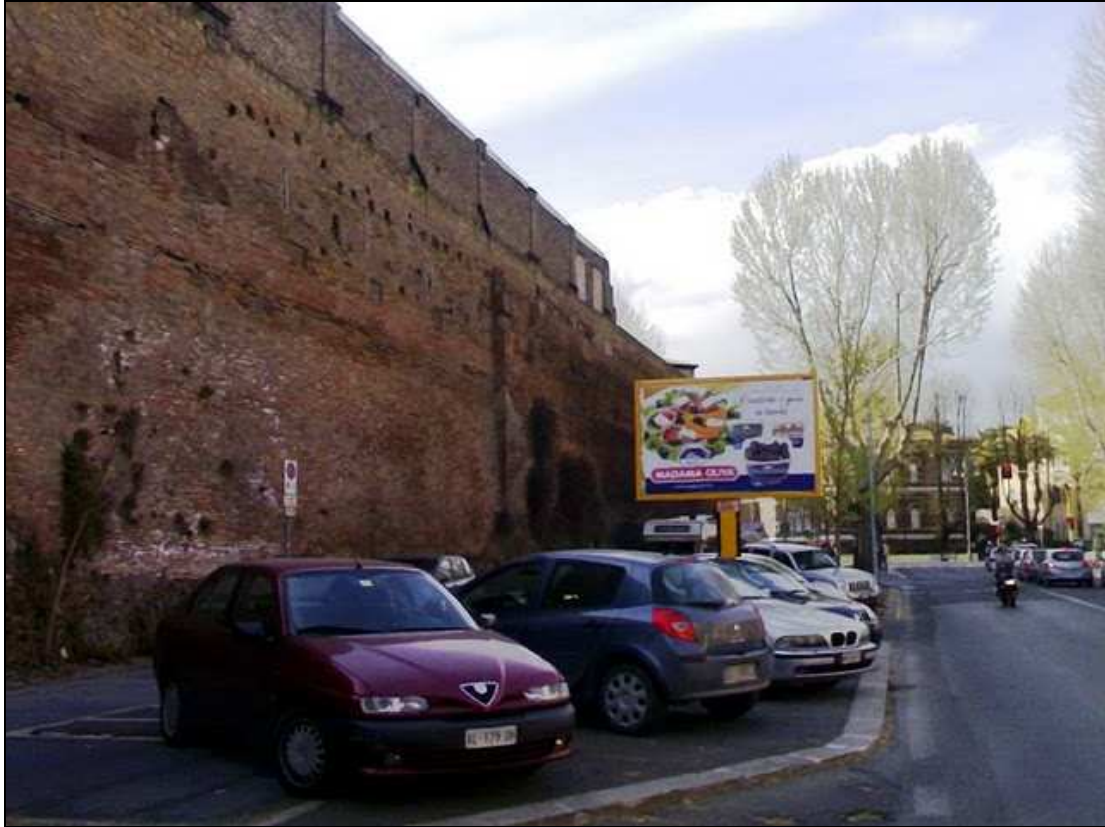
Impianto installato a ridosso delle mura aureliane in viale di Castro Pretorio, segnalato da VAS con messaggio di posta elettronica trasmesso alle ore 9,53 del 4 giugno 2010
