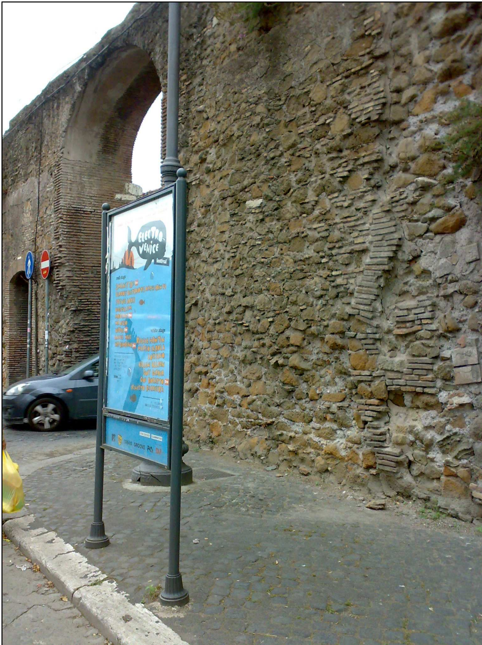
Impianto pubblicitario installato a fianco di Porta Portese (mura gianicolensi), segnalato da VAS con messaggio di posta elettronica trasmesso alle ore 15,49 del 20 giugno 2010
